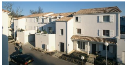
Intégration de l'habitat intermédiaire dans le style architectural régional. Mérignac (F)
